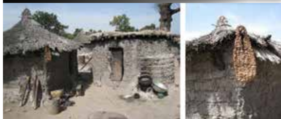
Grille à levure accrochée à la toiture d'une maison toussian. Détail. (Daniela Bognolo. Tapokon, Burkina Faso. 2008)
